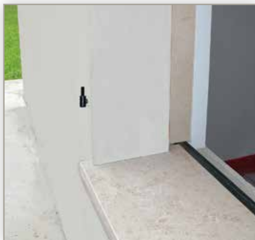
Spalla finita ad intonaco con supporto cardine installato
